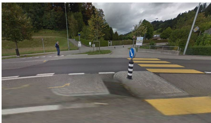
Abb. 12: Einmündung Ober- in Burgdorfstrasse mit Bushaltestelle Hübeli (Quelle. Streetview)
